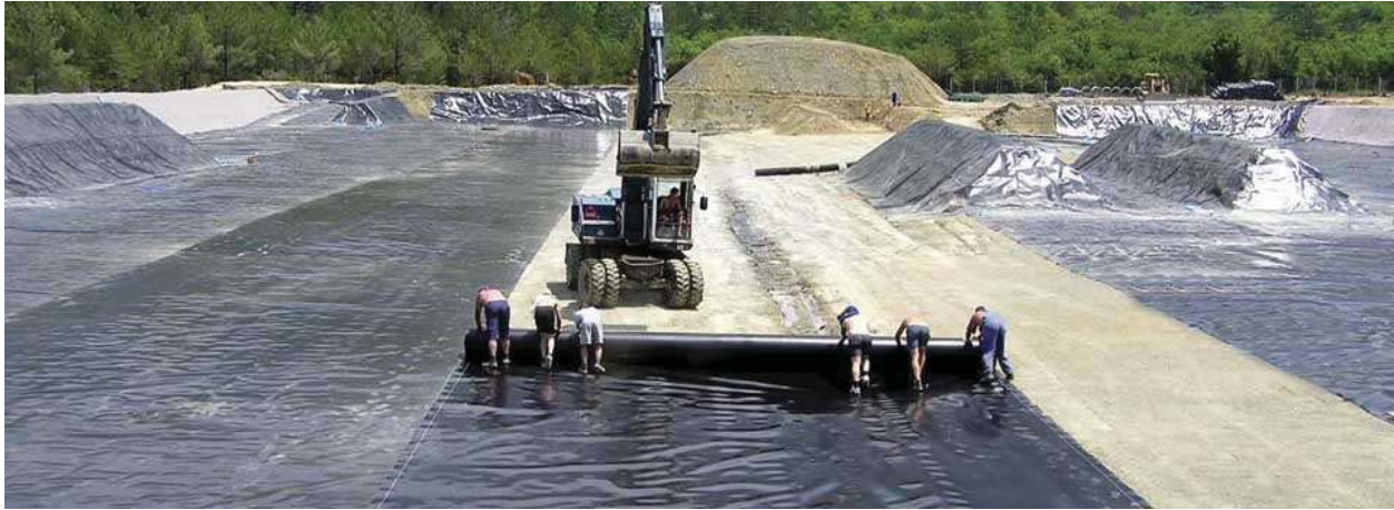
Slika 5. Prikaz procesa izgradnje deponije Možura
