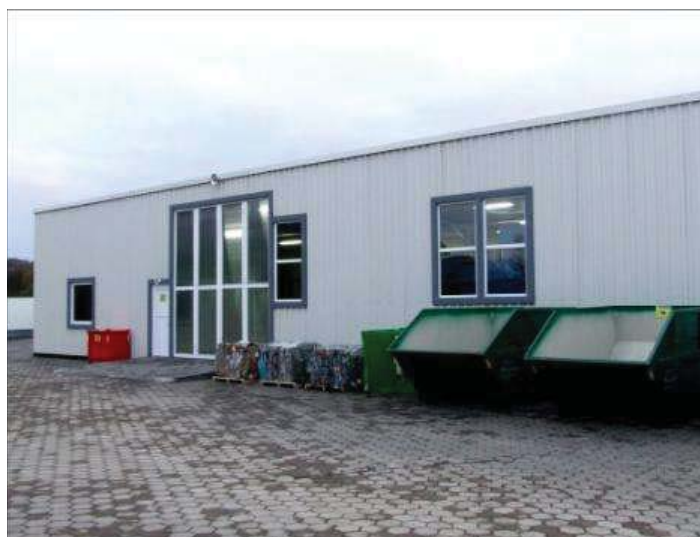
Slika 20. Hala za separaciju otpada - spoljni izgled
